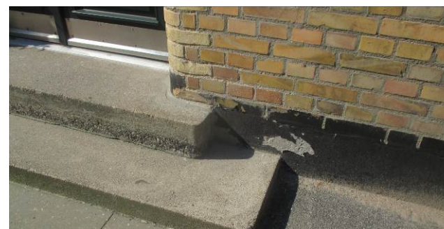
Mindre pudsskade på sokkel ved indgangsdør.
