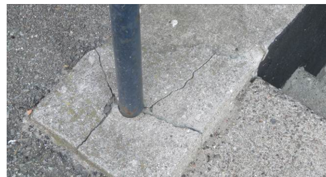
Revnedannelse ved rækværk til kælder.
