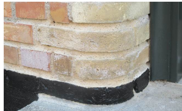
Sokkel ved indgangsdør, hvor fuger jævnligt bliver vedligeholdt.
