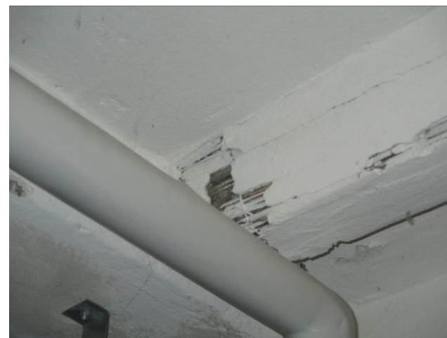
Brud på overfladen på etagedæk over kælder.
