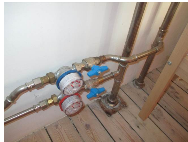
Nye vandinstallationer med afspærringsventiler og målere, som ikke er isoleret i lejlighed, samt fittings i messing.
