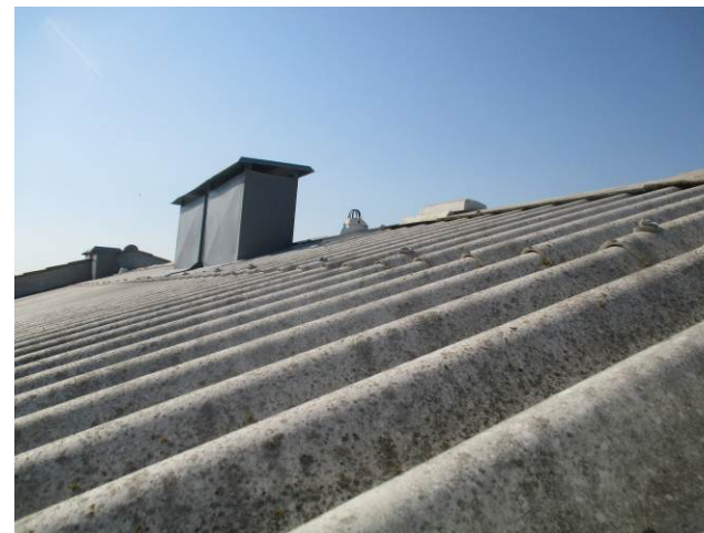
Tagbelægning er bølgeplader og brandkarm i baggrunden.
