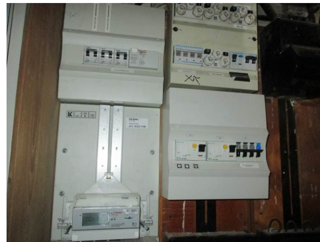
Fælles el-installation i kælder.
