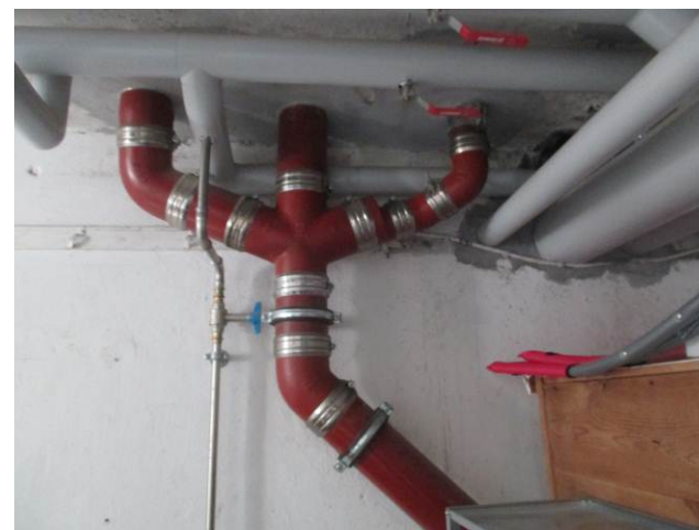
Faldstammer i kælder, uden rottespærre.
