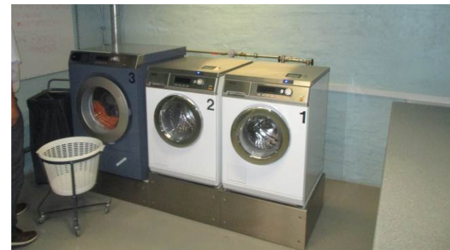
Vaskekælder med nye Miele-maskiner.
