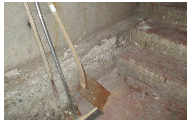
Kælderydervæg i fyrrum.
