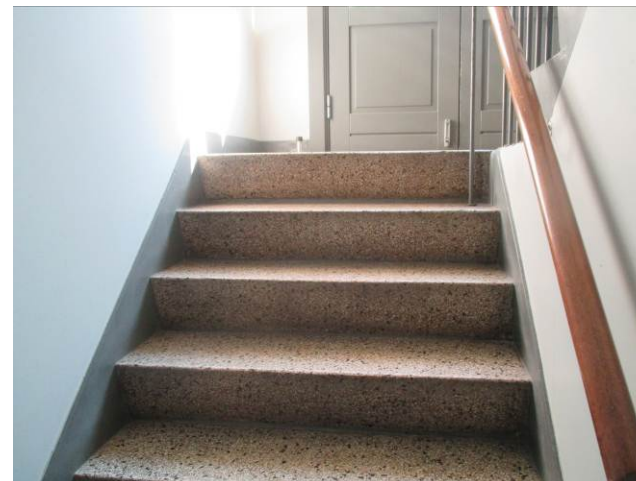
Trappe fra indgangsrepos og til kælder er af terrazzo.
