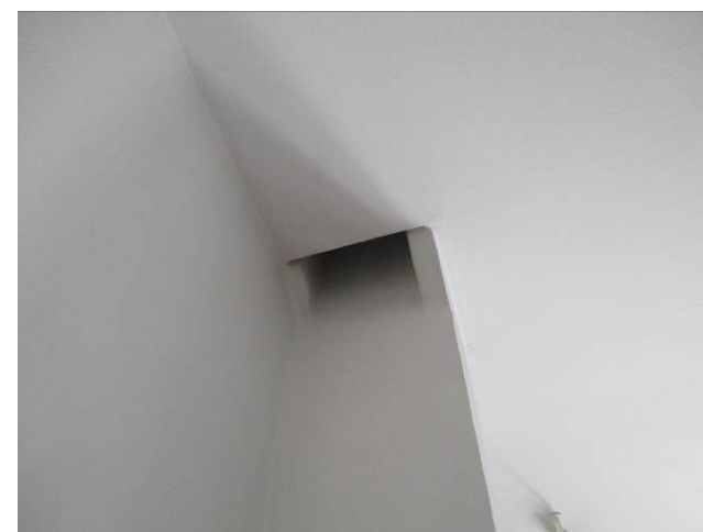
Ventilationshul i en af lejlighedernes køkken, som trænger til at blive renses.
