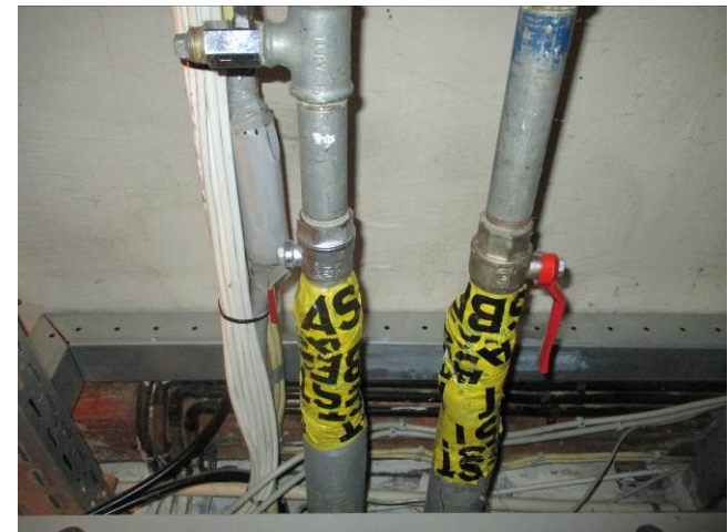
Manglende isolering på rør.
