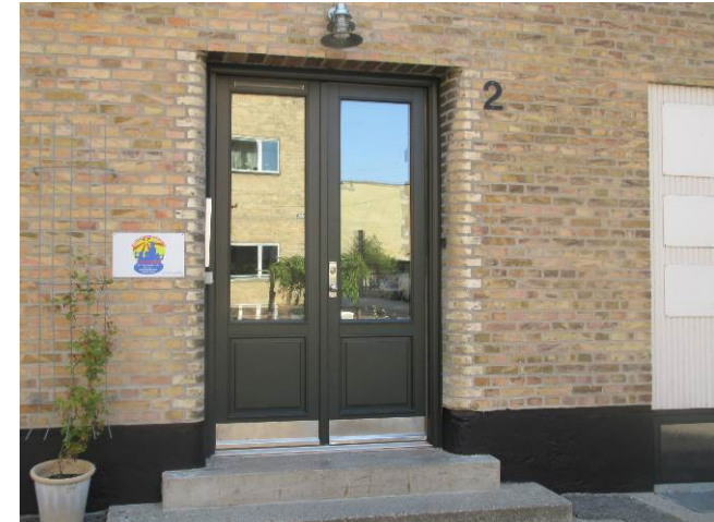
Opgangsdør til Tjørnerækken 2.
