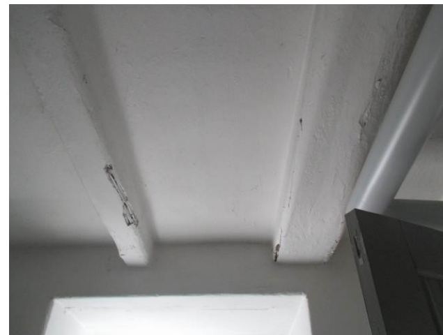
Etagedæk set fra kælder, brud på overflade.
