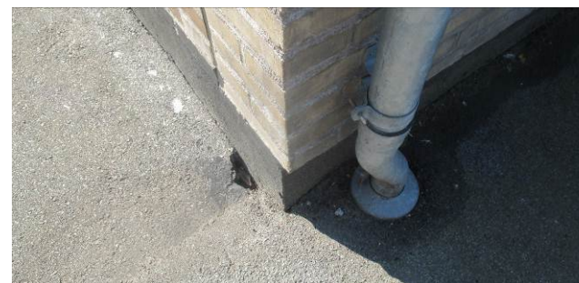
Hul i belægning ved husmuren på hjørnet af Prags Boulevard og Poppelrækken.
